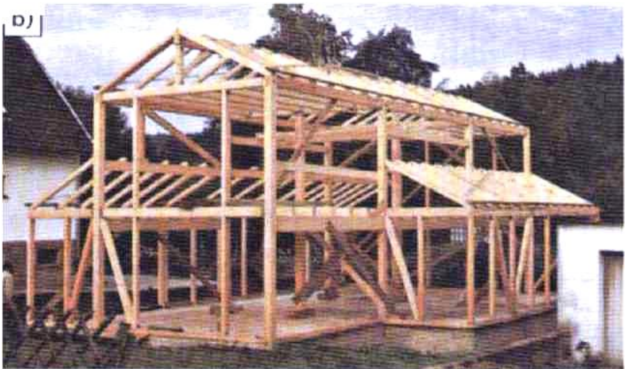
Obr. 3.11 Skeletový konštrukčný systém
